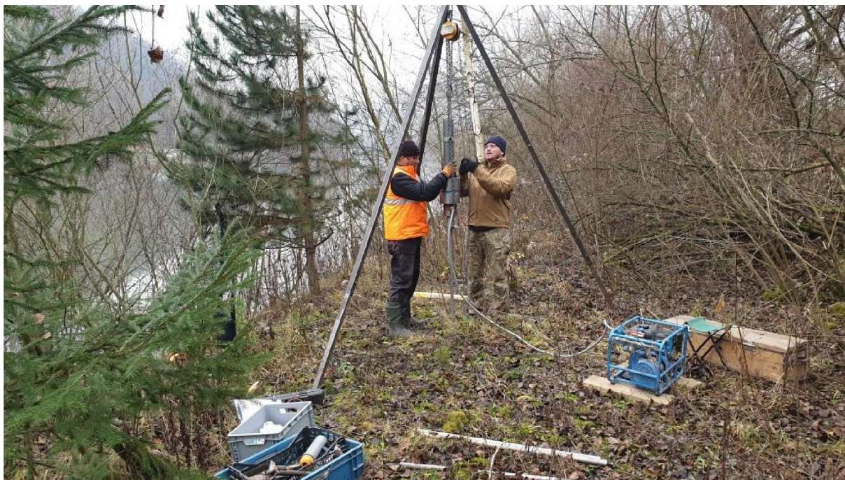
Obr. 3: Ukážka z realizácie penetračnej sondy na ľavom brehu Váhu
